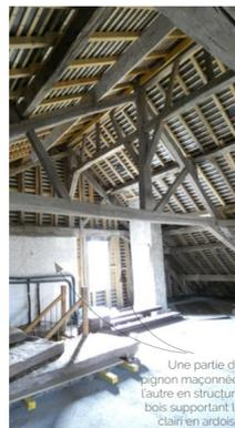
1. Ferme de la charpente à deux pans et aperçu dans le fond du support du clair sur le pignon des abbesse
