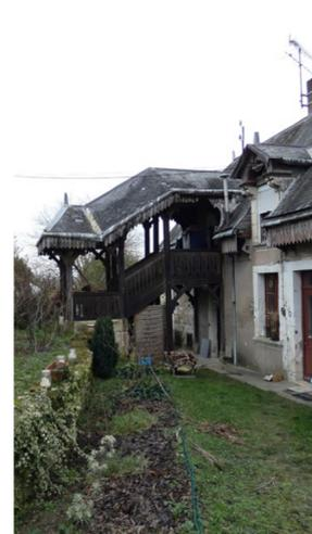
Façade ouest, escalier hors oeuvre vue de côté, donne accès à l'étage de la partie non communicante à l'intérieur et permet de passer d'un niveau de sol à l'autre
