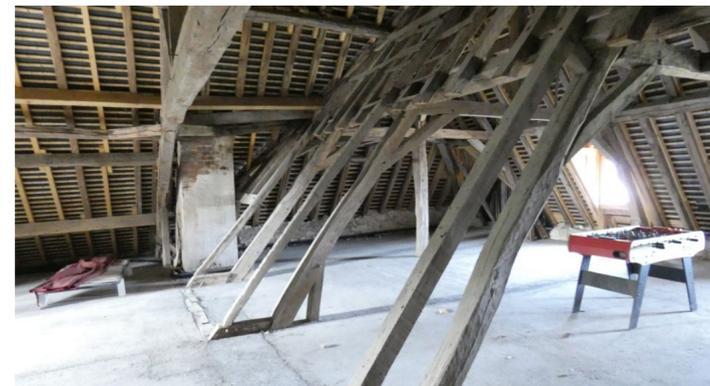
3. Jonction des deux charpentes. L'une pour une toiture à deux pans (à gauche) et la seconde à quatre pans
