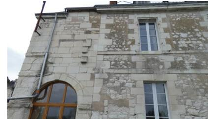
Façade nord du bâtiment des abbesse, le chaînage du mur et l'appareillage des pierres indiquant l'adjonction de la partie est
