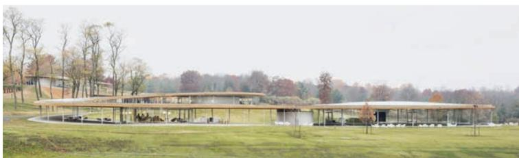
Le système constructif en caissons suit une trame de 80 cm par 100 cm qui permet d'avoir une grande portée, d'autant plus que celle-ci se fait dans les deux sens.
