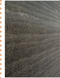
Béton de chanvre sur ossature bois
