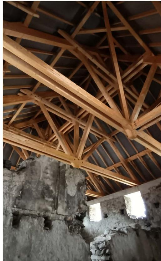
Fig.III.1.3. Dialogue entre la charpente actuelle et les murs massifs en ruine du dernier étage de la tour de Bellegarde
