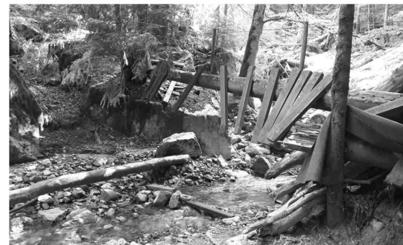
Fig.I.3.3. Passerelle du torrent de l'Épine, démembrée en 2018 par une coulée de lave torrentielle
